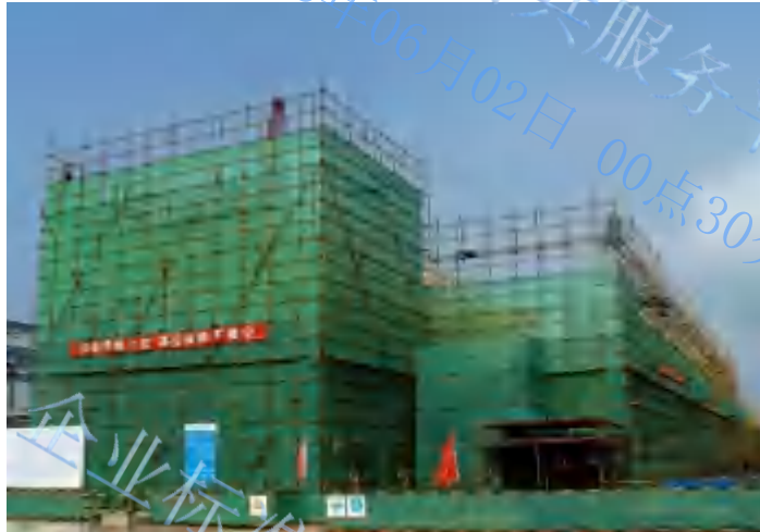
图 5.1 脚手架密目安全网示例
