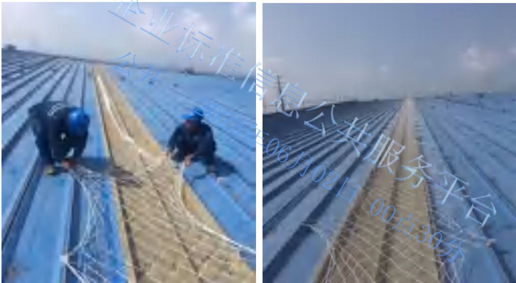
图 5.4 屋面采光带防护实例
