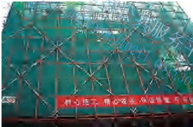
图 5.2 脚手架密目安全网示例
